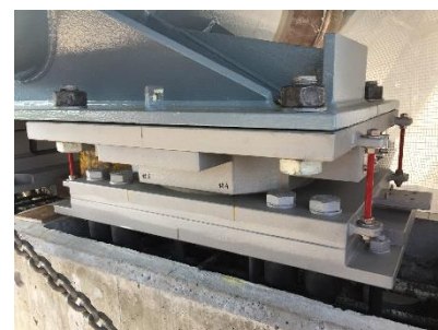
Bild 2: Druck-/Zuglager KZf, vormontiert und ausgerichtet, bereit für das Betonieren.
