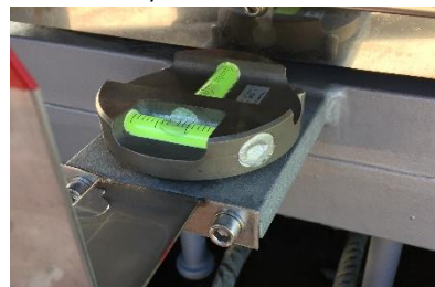
Bild 9: Einmessen vom Lager mittels 2-Achsen-Wasserwaage.
