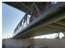
DB Fachwerkbrücke Hbf Ulm (DE)
