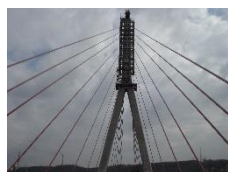
Elbebrücke Niederwartha (DE)
