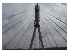
Elbebrücke Niederwartha (DE)
