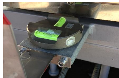
Bild 7: Einmessen vom Lager mittels 2-Achsen-Wasserwaage.
